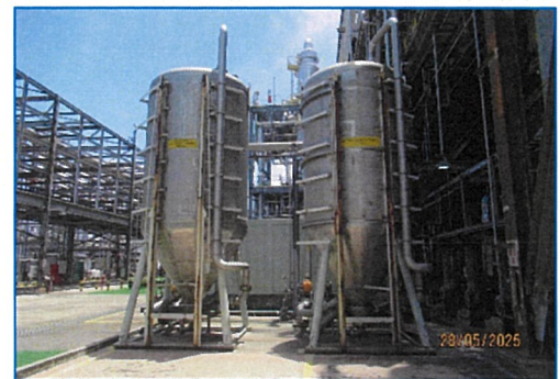
ภาพถ่ายที่ 2.2-6 ระบบดูดซับด้วยถ่านกัมมันต์ ของส่วนผลิต BPA
