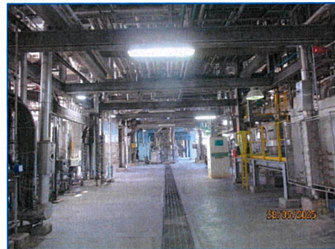
ภาพถ่ายที่ 2.2-12 รังระบายน้ำภายในพื้นที่โครงการ
