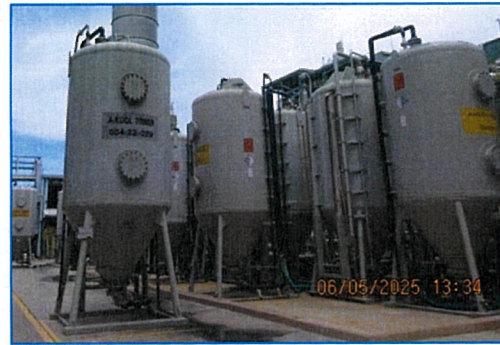
ภาพถ่ายที่ 2.2-10 Activated Carbon Adsorber ของส่วนผลิต PC
